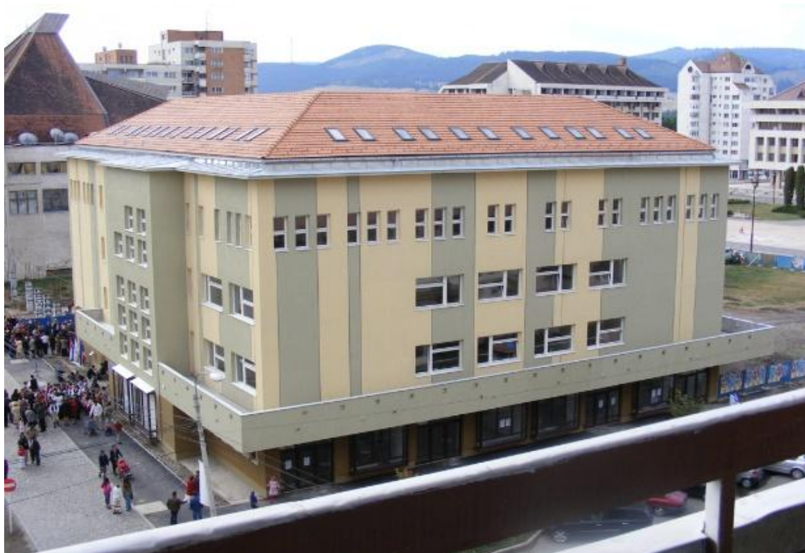
Figura 1: Clădirea Liceului de Arte „Nagy István” din Miercurea Ciuc, inaugurată în 2008, situată în centrul municipiului.
